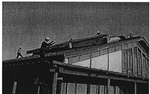
↑ 屋根の修復工事をする仲間 (築 6 年程度、栗原市一迫地区)
