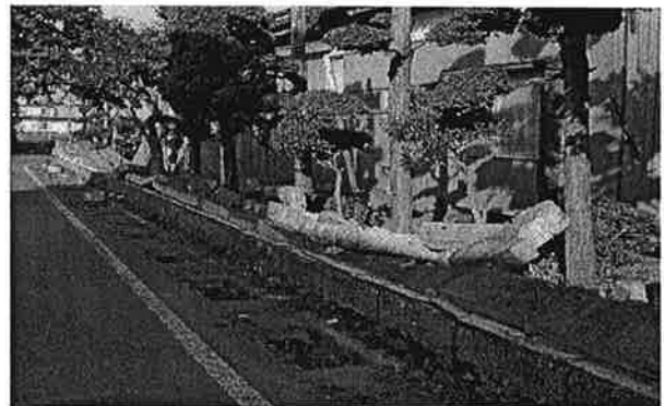
↑ 石積み塀は完全に倒れたが住宅は無傷 (築 30 年程度、栗原市志波姫地区)
