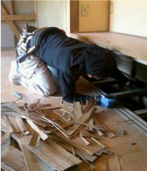
大槌町の川村宅の修繕をする建設横浜班の仲間。
