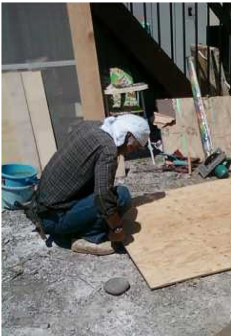
桜木町の岩井宅で作業する土建班の仲間。
