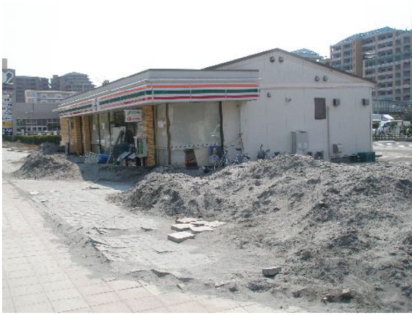
町中至るところに液状化で溢れた砂の山ができています
