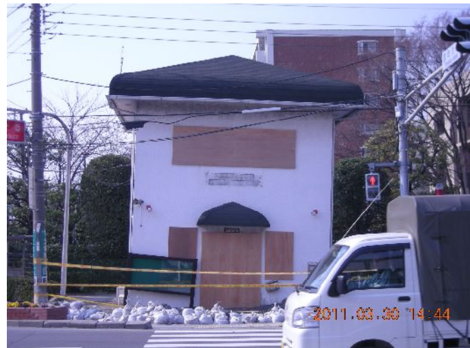
右に傾いた交番、電柱は左に傾いている
