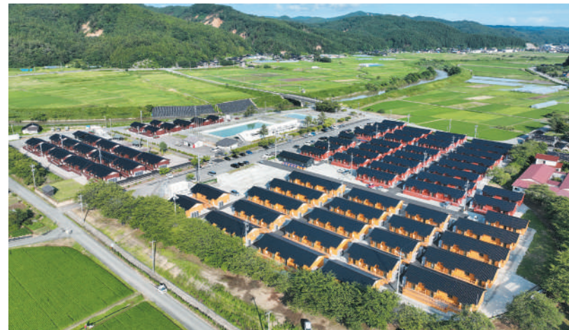
1 団地として過去最大の 268戸の応急仮設木造住 宅を建設した石川県輪島 市町野の仮設団地 (2024.8)
