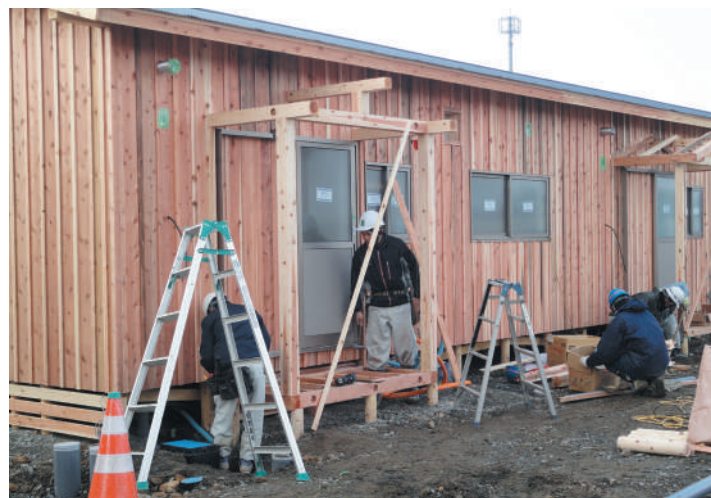
東日本大震災を受けて、 福島県いわき市で応急 仮設木造住宅を建設 (2011)
