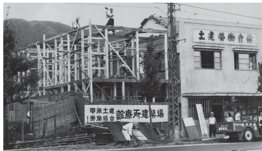
建設中の土建診療所（1952年、昭和27年）
