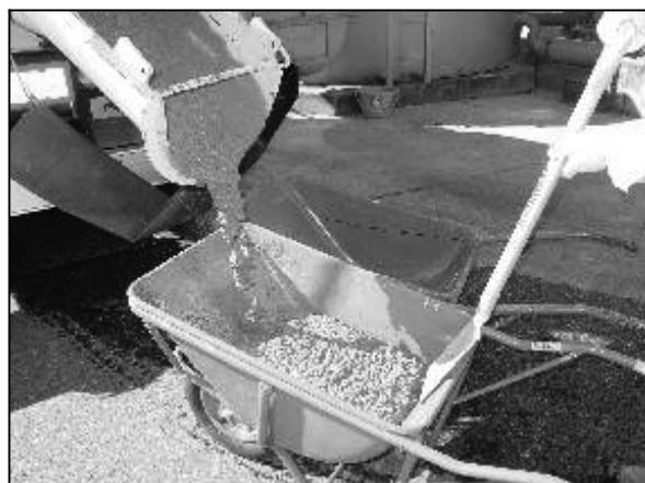
また、ポンプ車の筒先から採取する場合は、排出されたコンクリートの山の3カ所以上から採取して下さい。（締め固めの前に行ってください。）
