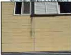
西面 シーリングの破断部分から隙間が確認され、雨風の侵入が疑われます。
