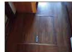
床下収納口 点検口の蓋部分及び周囲の板がたわみませ、すでに破損する状況ではないと考えられますが、補修の検討をお勧めします。
