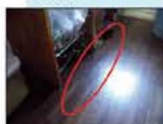
浴室 浴槽や洗面によりフローリング巻目の付着部分及びひび割れ、剥離を認めます。このまま進行するとけがの恐れがありますので、補修の検討をお願いします。
