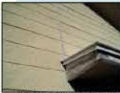
壁面: 浮き・目地部分に浮きが発生しており、下地の木材が露出し、部分的に腐食が確認されています。塗装を行うなど早急な補修をお勧めします。
