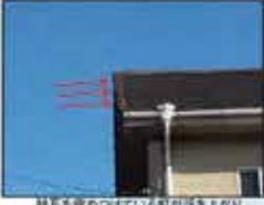
瓦と屋根のつなぎ目の釘が浮き上がり、床瓦にすれが感じられます。脱落の可能性があり、早急の補修をお勧めします。
