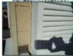
東面 サイディングと取付戸枠の接合部のシーリング破断部分から隙間が確認され、雨風の侵入が疑われます。
