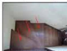
浴室部分、浴槽に水がたまりが見受けられます。浴室の材の継ぎや剥離等が推察されます。構造上の支障ははないと推察されますが、補修の検討をお願いします。
