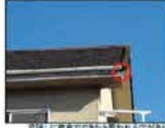
瓦葺き屋根: 浮きが確認されます。水漏れが考えられるため、早急な補修をお勧めします。
