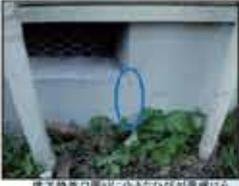
地下室換気口裏面に小さなひびく目が見受けられましたが、幅も小さく、数箇所仕上げのモルタル部分のみのひびと考えられ、構造体への影響はないと判断されます。
