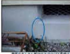
表面のモルタル部分のみのひびく目が見受けられますので、構造体への影響はないと判断されます。
