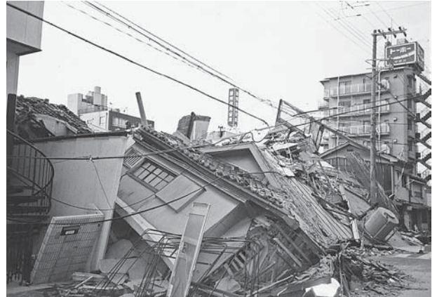
阪神・淡路大震災で倒壊した住宅
