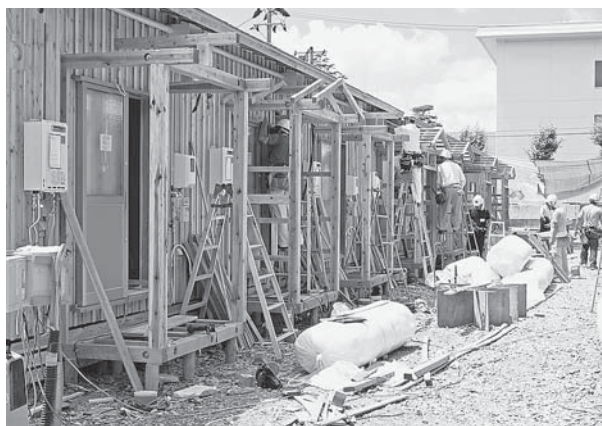
応急仮設木造住宅の建設に励む仲間
