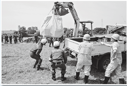
大型土嚢つくり
