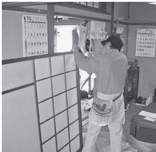
ボランティア活動で高齢者宅の住宅修繕を行う仲間
