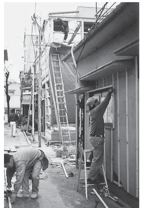
木造住宅工事相談センターで従事する仲間
