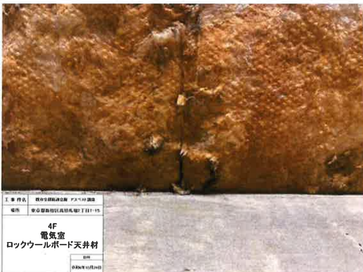
件名：既存全建総連会館 アスベスト調査 撮影日：2024年10月28日 採取状況：採取前 調査地点：4F 電気室（天井） NO.3
