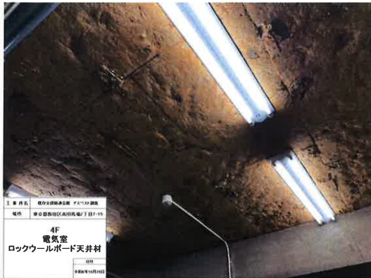
件名：既存全建総連会館 アスベスト調査 撮影日：2024年10月28日 採取状況：採取箇所 調査地点：4F 電気室（天井） NO.3
