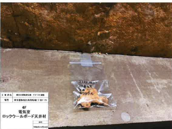
件名：既存全建総連会館 アスベスト調査 撮影日：2024年10月28日 採取状況：採取完了 調査地点：4F 電気室（天井） NO.3
